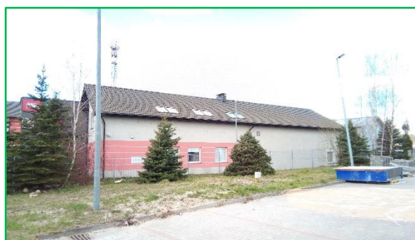
Rys. Widok wschodniej połaci Obiektu budowlanego P.
