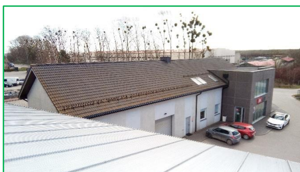
Rys. Widok zachodniej połaci Obiektu budowlanego P.
