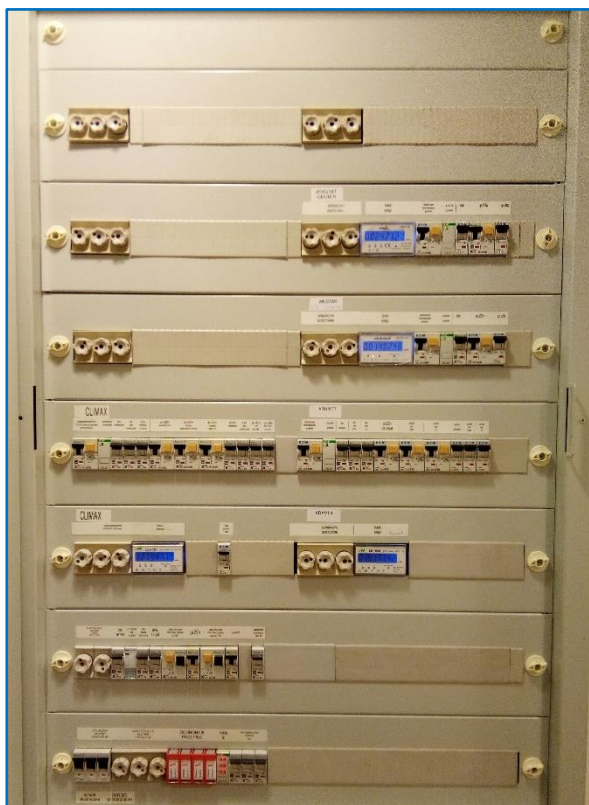
Rys. Obiekt biurowy L wyposażony jest w 2 niezależne rozdzielnicze poziome, zabezpieczające obwody elektryczne na poziomie kondygnacji T1 (lewa) i T2 (prawa). W obrębie rozdzielnic T1 i T2 nie istnieje możliwość zlokalizowania falowników sieciowych instalacji fotowoltaicznej ze względu na brak możliwości zagwarantowania przydatności eksploatacyjnej.
