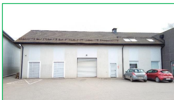
Rys. Widok zachodniej połaci Obiektu budowlanego P.
