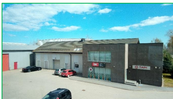
Rys. Widok zachodniej połaci Obiektu budowlanego P.
