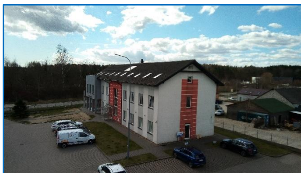
Rys. Widok wschodniej połaci Obiektu budowlanego P.
